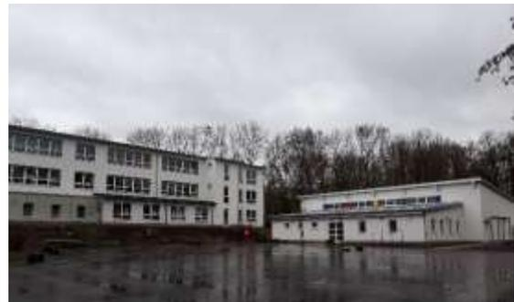
Eine größere Investition zur Energieeinsparung wurde an der Grundschule in Hohenroda von 2014 bis 2015 getätigt. Hier wurde die Außenfassade des gesamten Schulgebäudes gedämmt und somit eine geringere Heizlast des gesamten Gebäudekomplexes erreicht. Des Weiteren erhielt die Schule 2014 eine neue Pelletanlage zur Wärmeversorgung.
