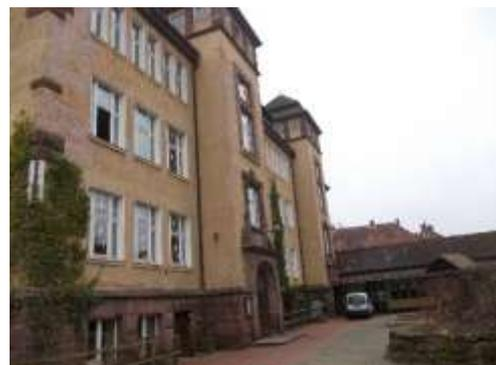
Hier erfolgte 2018 ein Austausch sämtlicher Fenster im Schulgebäude, was zu einer leichten Verbesserung des Wärmeverbrauches führte. Des Weiteren wurden die Dachflächen neu eingedeckt und in einem Teilbereich auch Wärme gedämmt.
